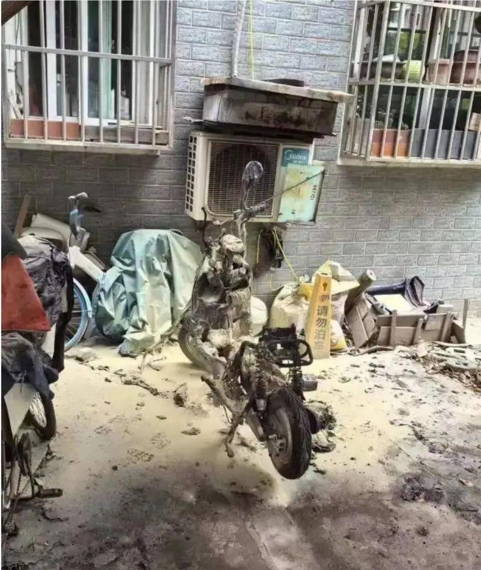
电动自行车在户外私拉乱接电线充电，裸露在外的电线经过暴晒、雨淋，容易漏电引发火灾，如果电线老化或者电动自行车本身电瓶出现了问题，更容易发生火灾。
